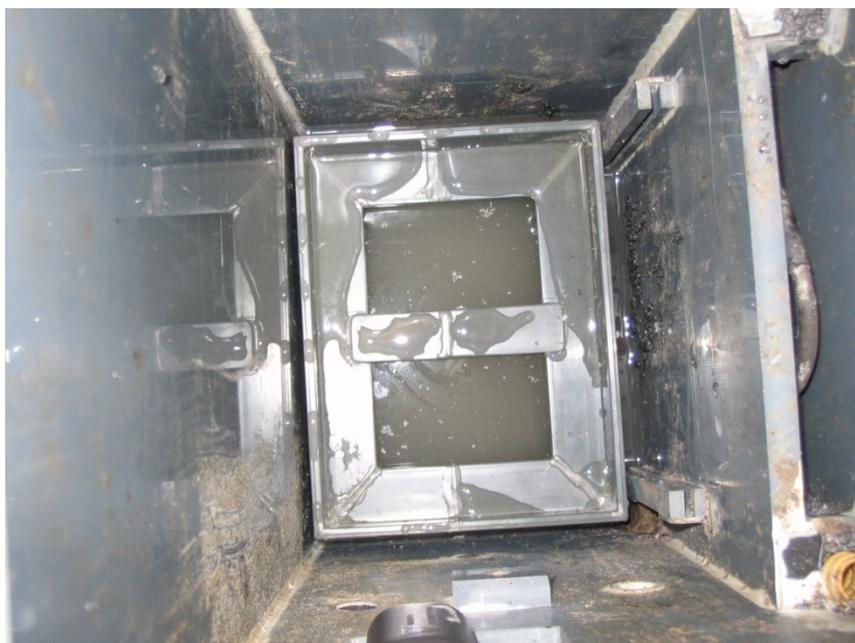
*Fotografia 5.6 Vista dall'alto della seconda camera anaerobica svuotata in cui è già stato inserito il sostegno in PVC.*
